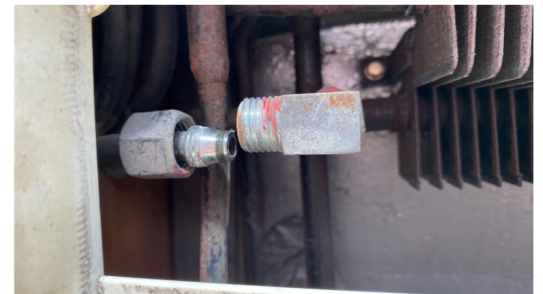
De gasleiding is nu los
