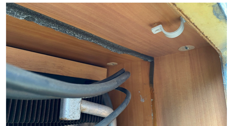
Maak één schroef los van het zadel voor de kabels
