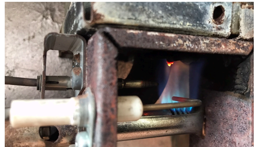
Brander, ontsteker en thermo koppel zijn schoon
